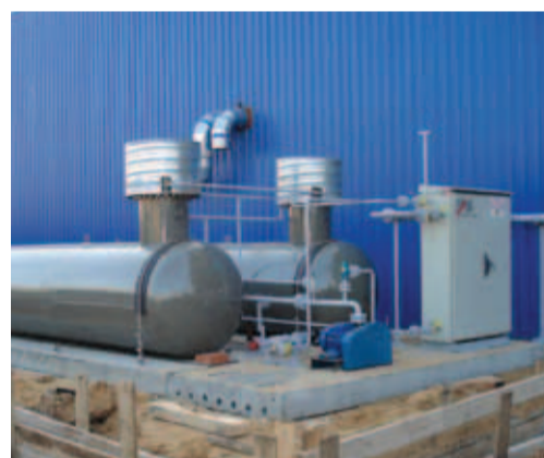
Схема газоснабжения СУГ в газгольдерах.
